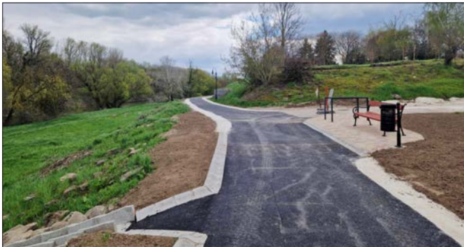
Végéhez közeledik a kerékpárút felújítása
