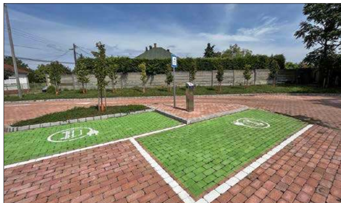
Az óvoda melletti Körtés utcában parkolókat alakítottunk ki, megoldottuk vízelvezetést, valamint elektromos töltőállomás is lett ott
