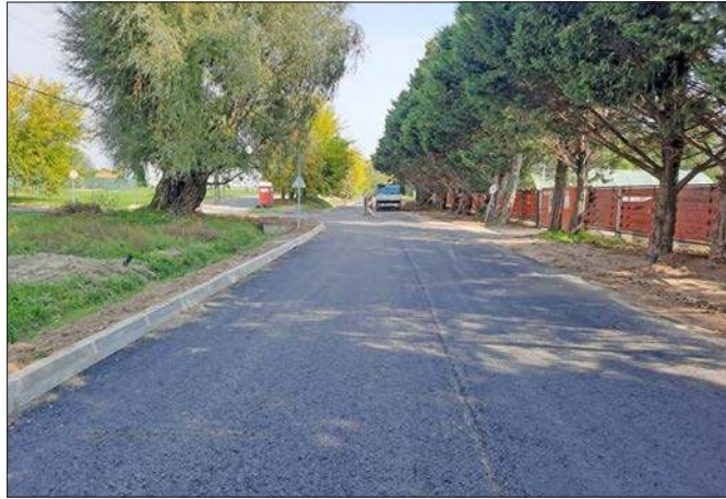
A 2023-as esztendő legnagyobb beruházása Rácalmásban a Venyimi út aszfaltozása volt, a lakosság nagy megelégedésére
