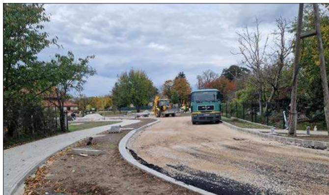
Számos útépités valósulhatott meg tavaly, ilyen volt például a Tolszto utca aszfaltozása és csapadékvíz-elvezetése
