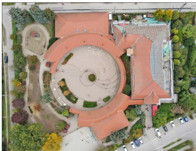
Dron-felvétel az általános iskola tetőszerkezetének felújításról
