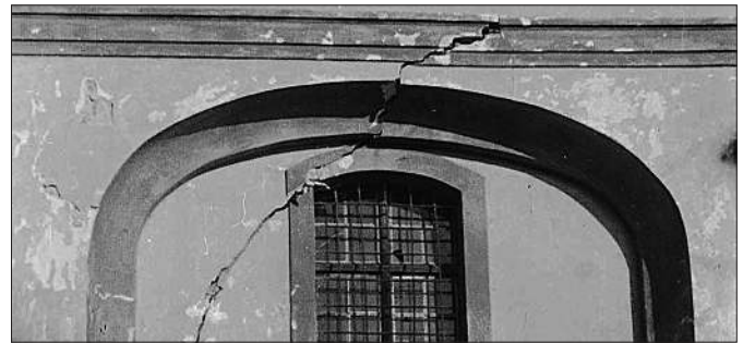
1960-as évek, repedések az északi falon
