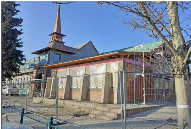
Év végére elkészül a régi városháza átépítése, felújítása
