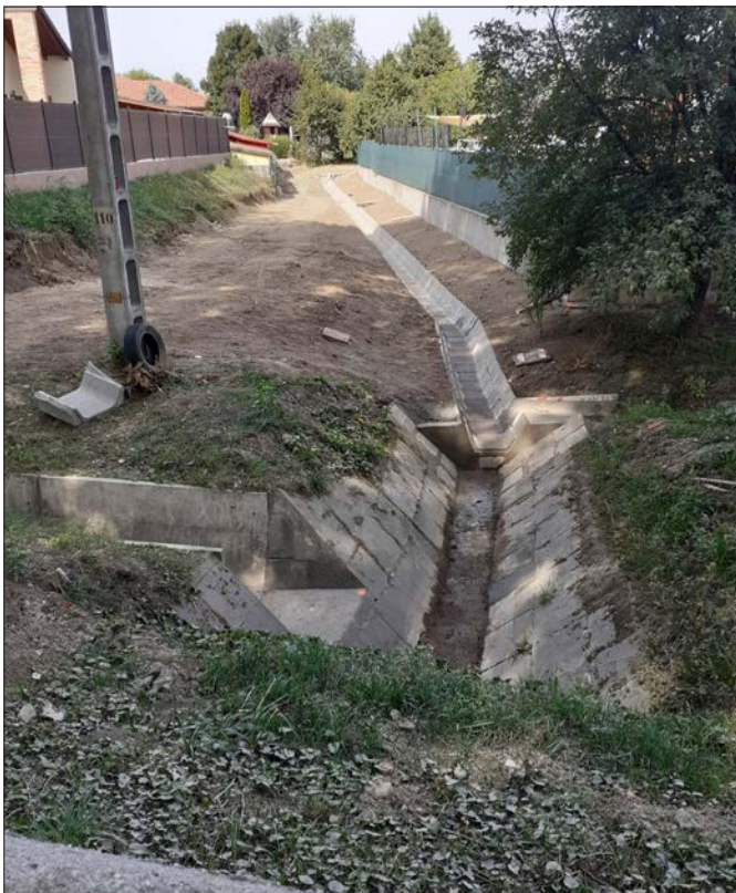
A Viola utcában már el is kezdte a kivitelező a munkálatokat. A csapadékvízvezető már készül, ahogyan arról a helyszínen készült felvételünk is tanúskodik
