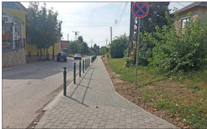
Új, térköves járdát építtetett az önkormányzat az iskola utcájában, hogy a gyerekek biztonságosan közlekedhessenek
