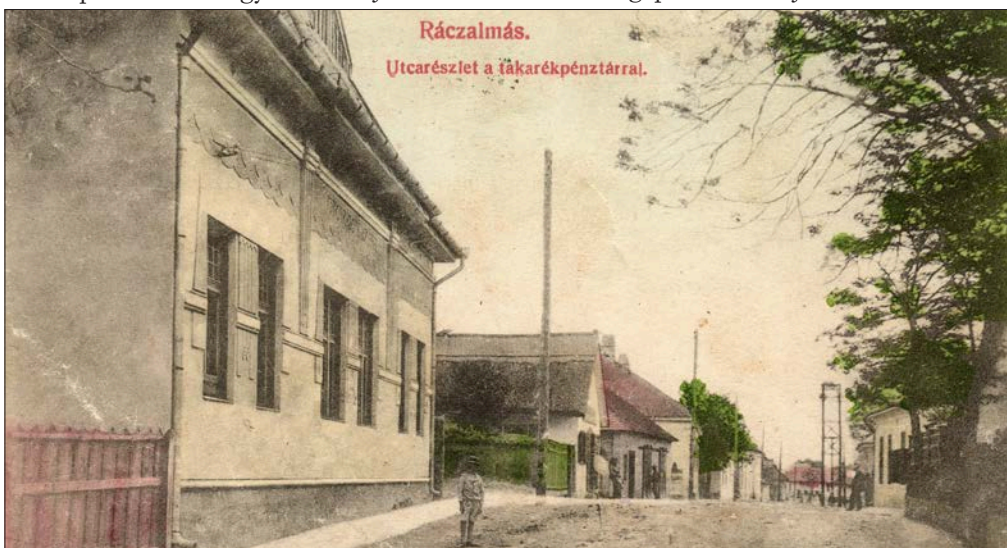
A Takarékpénztár épülete a Kossuth Lajos utcában
