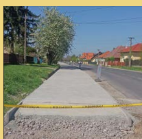
Kerékpárút, járda és vízelvezetés épül a Kulcsi úton 3. oldal
