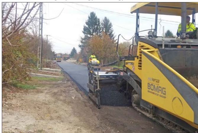
Megoldotta az önkormányzat a Sirály utca felújítását, aszfaltozását és vízelvezetését
