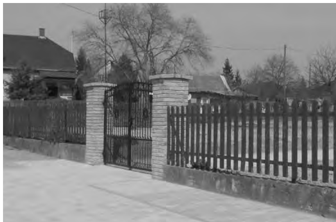
Az önkormányzat beruházásában kétszárnyú kaput nyitottak a temető kerítésén a Millenniumi park felől. Hulladékgyűjtő konténert is kihelyeznek oda, hogy biztosítsák a temető rendjét, tisztaságát
