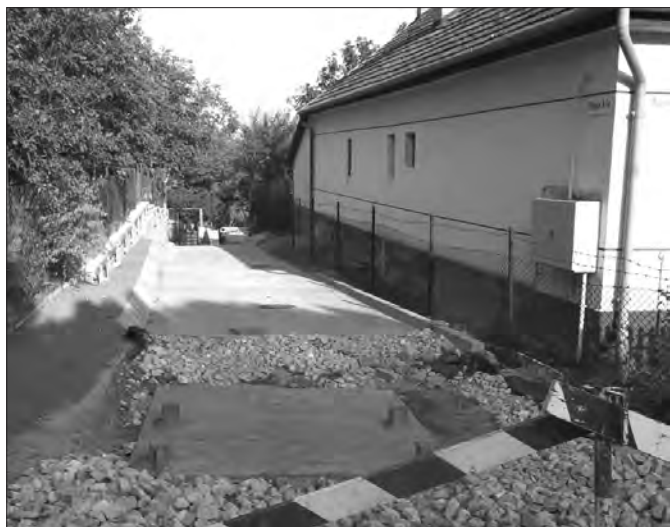
Gőzerővel dolgozott a kivitelező ófaluban: a partfal-megerősítés II/A üteme után a II/B is folyamatban van, és jelentős pályázati támogatásból valósul meg
