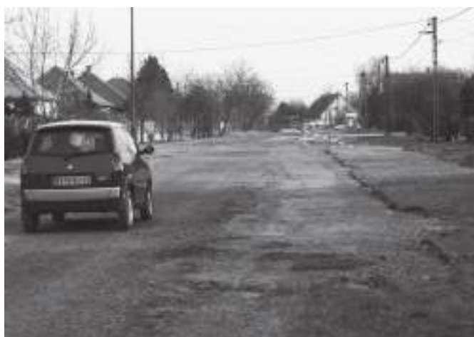
Az útlalap kialakításával elkezdődött a Révai, valamint Tóth Árpád utca helyreállítása. A munkák jövő tavasszal fejeződnek be
