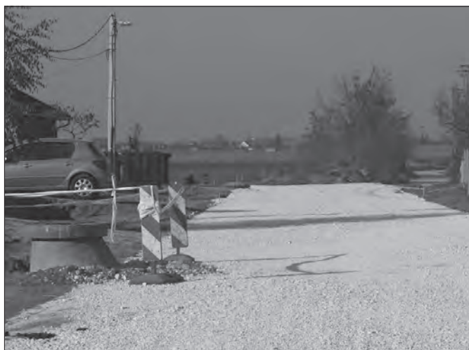
Elkészült a Pacsirta utca útalap építési munkálataival a kivitelező Duna-Via Kft. A lakók mostantól megfelelő körülmények között közlekedhetnek településünknek azon a részén is. A beruházás önkormányzati forrásból valósult meg
