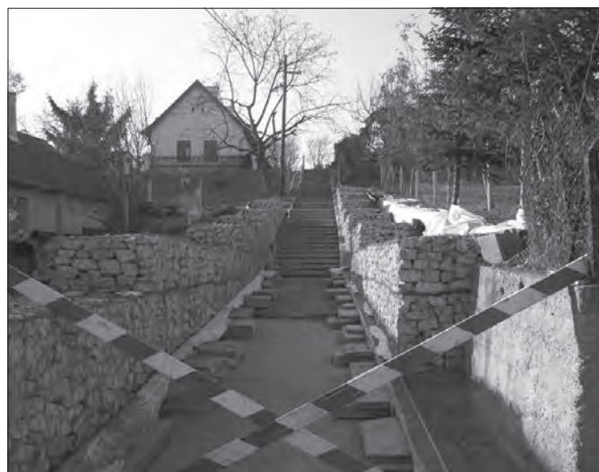
Jól halad a kivitelező a partfal stabilizálásnak II/A ütemű munkálataival. A beruházásra – amely meggátolja a szakadópart talajmozgásait – 357 millió forint pályázati támogatást nyert Rácalmás
